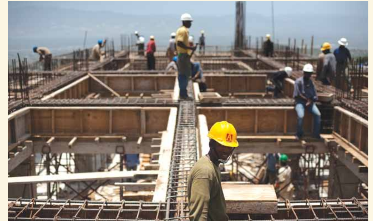
Des travailleurs du bâtiment « montent un étage » du Royal Oasis Hotel.
