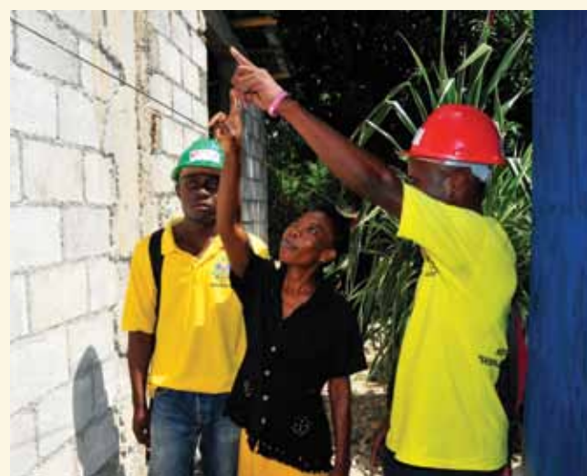
Anne Marie examine les réparations effectuées sur la maison dont elle est propriétaire, qui ont été facilitées par la Fondation panaméricaine de développement.
