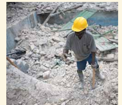
Un ouvrier du bâtiment d'Architecture for Humanity fouille les gravas.
