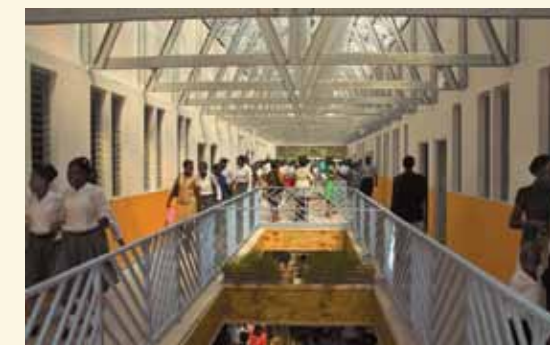
Des élèves parcourent les couloirs du collège du Sacré cœur de Port-au-Prince. L'établissement historique a été rebâti par l'entreprise du bâtiment KayTek avec une nouvelle charpente métallique GaMa.
